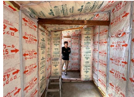
断熱材を施工
